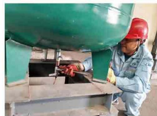
为提高压缩空气品质,保证设备用气点正常运行,7月5日,动力保障车间对空压机后各储气罐切水阀进行更换工作。由于原切水阀管径较粗,并位于储气罐正下方,操作不便的同时,容易造成浪费。经过更换后的切水阀操作更加便捷,不仅提高了压缩空气的品质,还降低了员工的劳动强度,减少了浪费风险,为公司发展提质增效贡献力量。
